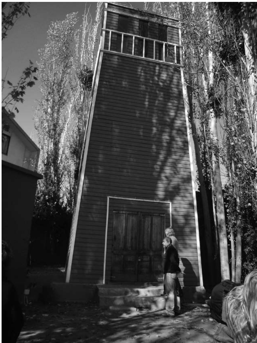
Reconstrucción de la antigua torre de agua, Parque por la Paz Villa Grimaldi
